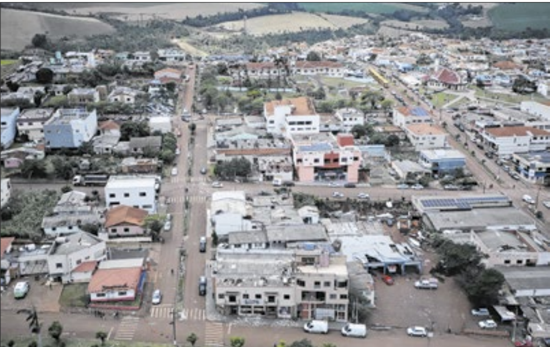
As verbas serão aplicadas em obras emergenciais de reconstruções
