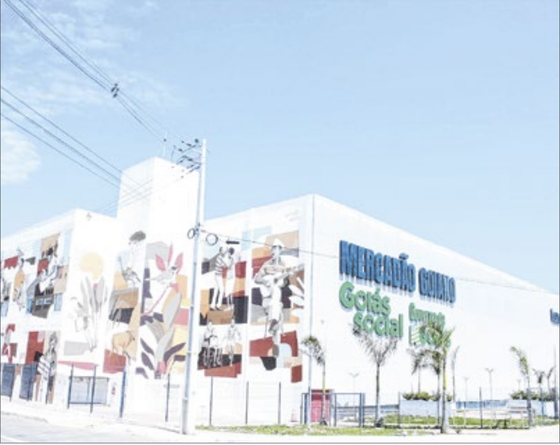
O novo espaço vai substituir a antiga Feira do Entorno e entregará à população um equipamento com estrutura moderna e permanente
