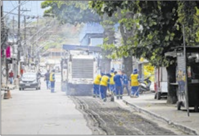
Prefeitura de Nova Iguaçu deu início às obras na rua
