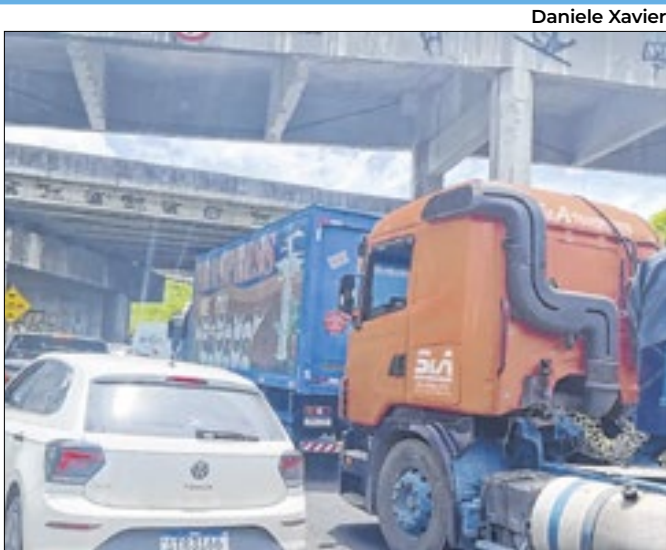
Outra ocorrência foi registrada no km 94
