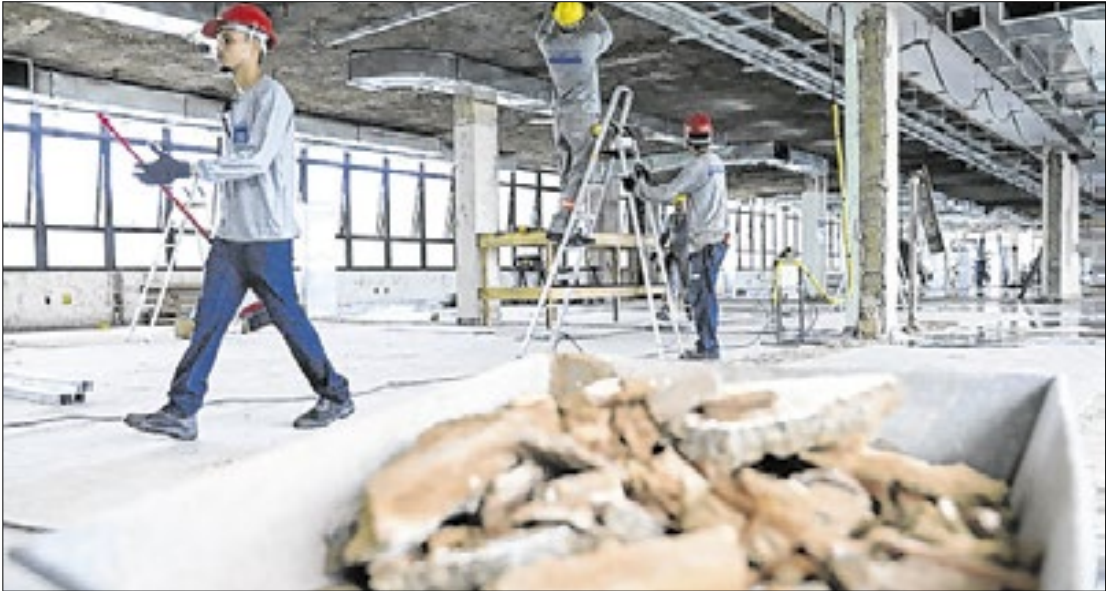
O andar do centro cirúrgico propriamente dito já passou pela demolição das antigas divisórias e avança agora para a construção da divisão das salas cirúrgicas
