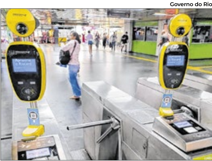
Governo do Rio Equipamentos são instalados na Central do Brasil
