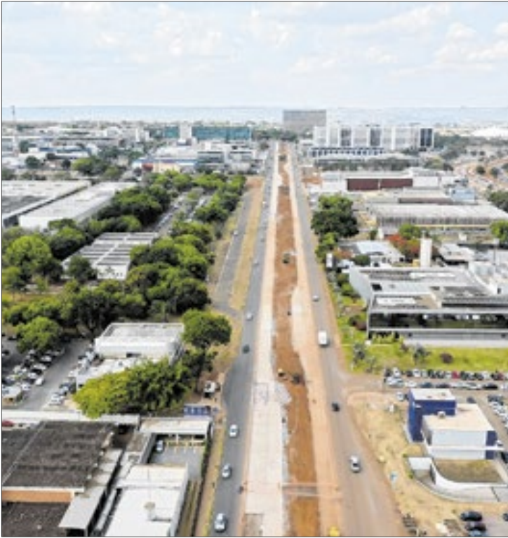
Corredor de ônibus é parte das obras na Epig
