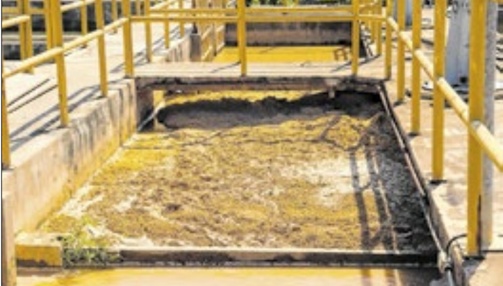
Alto nível de impurezas do Rio Acre afeta tratamento
