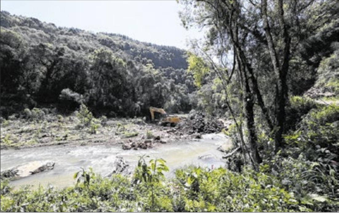
Dos 32 municípios contemplados na região, em 21 os trabalhos estão em execução
