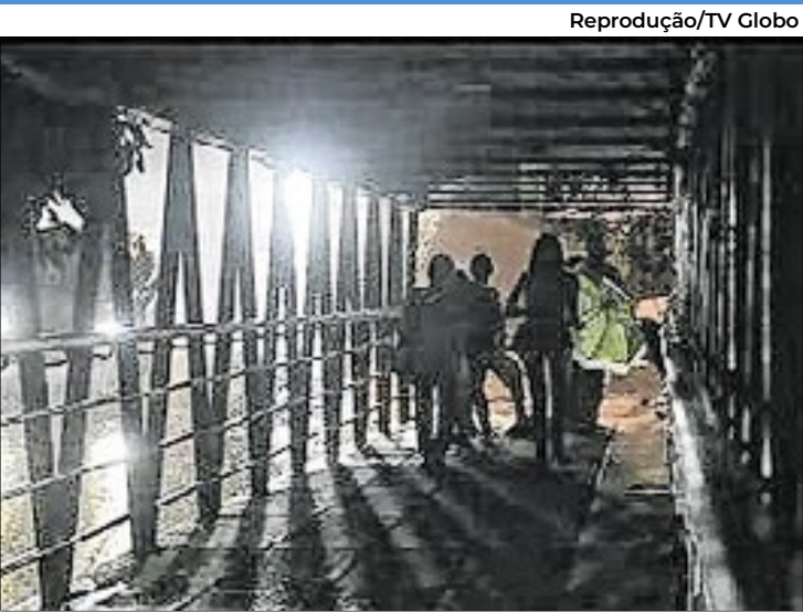
Pedestres reclamam da falta de iluminação em passarela na EPIA
