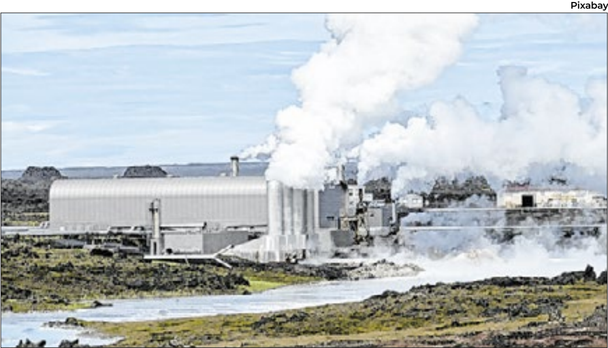
Usina quase dobraria a emissão de CO2 na atmosfera do DF Newton Vieira/Movimento Salve o Rio
