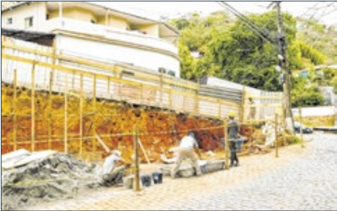
Cortina atirantada na Rua Guilherme Daumas Nunes
