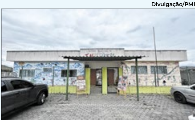
Unidade terá a construção de quatro novas salas
