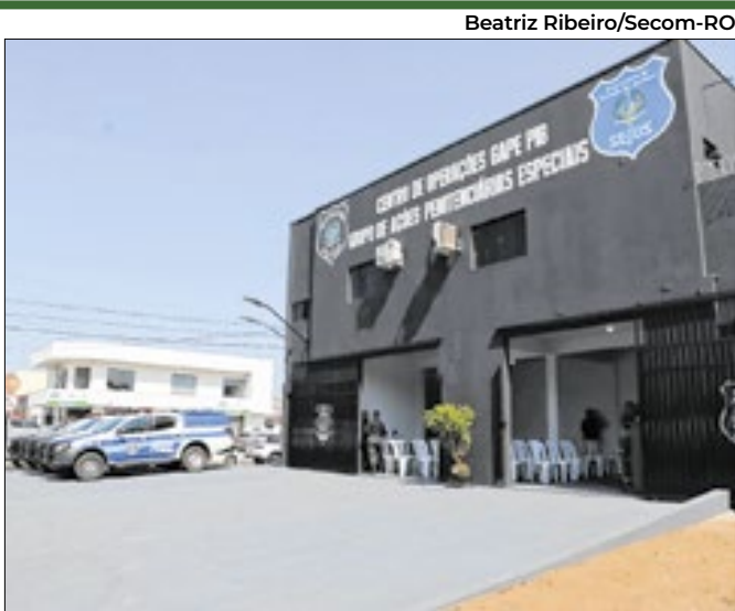
Unidade construída por reeducandos em Pimenta Bueno
