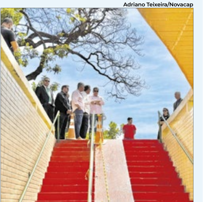
A Diretoria das Cidades da Novacap responde pela reforma das passagens subterrâneas. Na Quadra 102 da Asa Sul, a obra foi concluída
