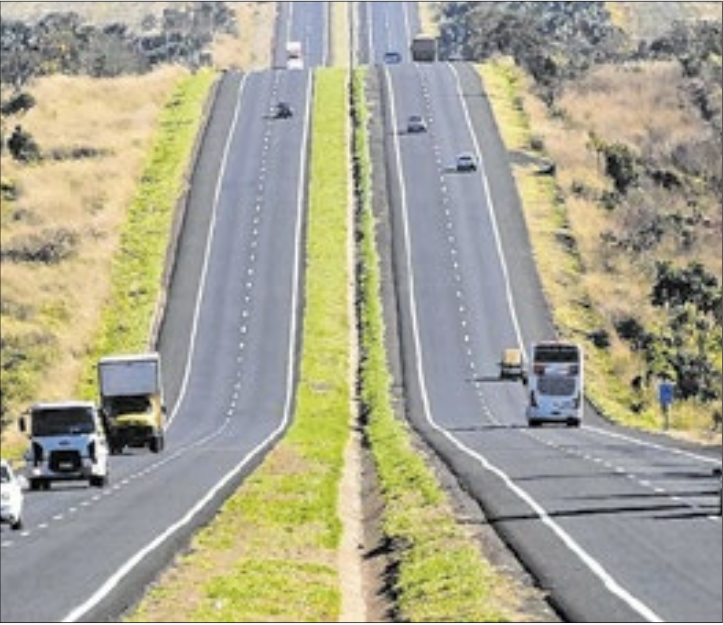
As obras que deverão gerar 557 empregos
