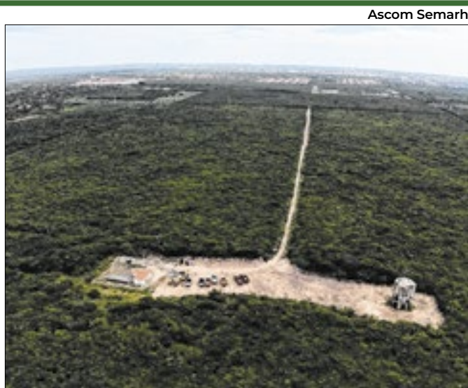
Obra para construção da maior usina de hidrogênio
