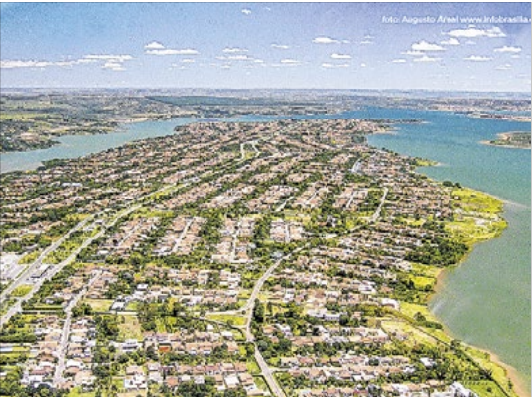
Medida aprovada pelo Conplan regulamenta ocupações e prevê desobstruções dos becos nos lagos Sul e Norte
