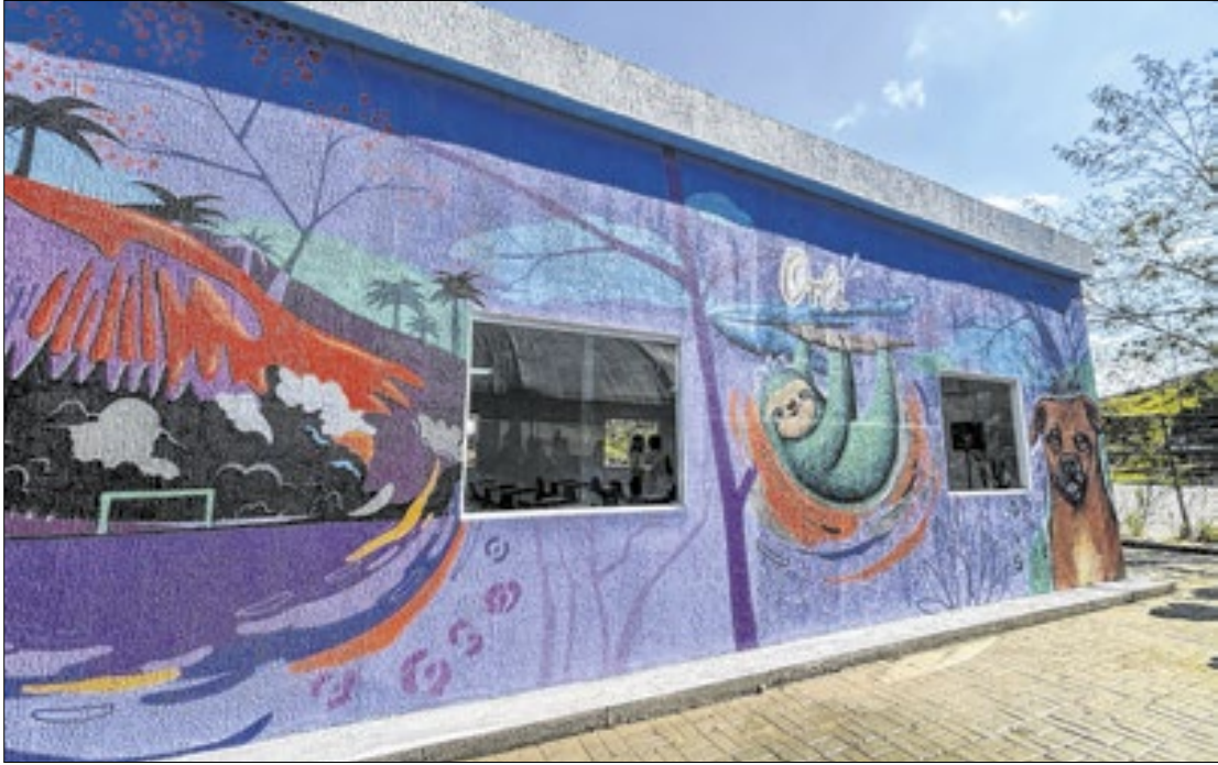
O novo auditório vai possibilitar a realização de oficinas, projetos e atividades ambientais
