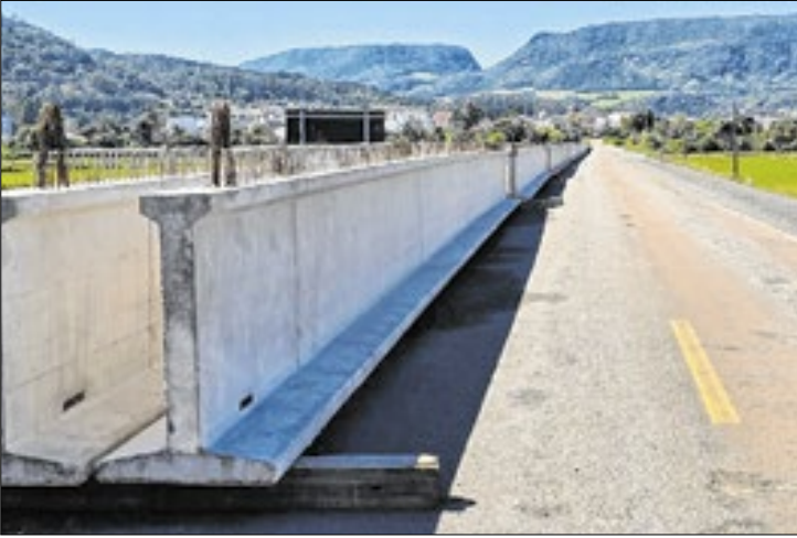
Estruturas irão substituir as danificadas pelas enchentes
