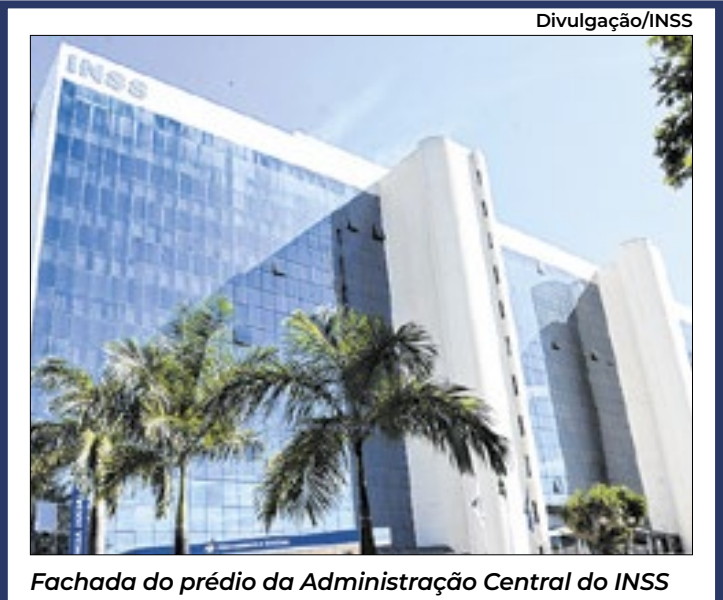
Fachada do prédio da Administração Central do INSS
