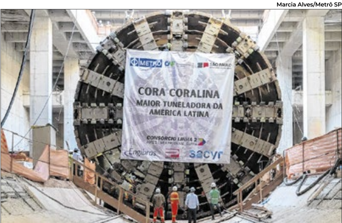
Tuneladora chega ao canteiro da Estação Penha
