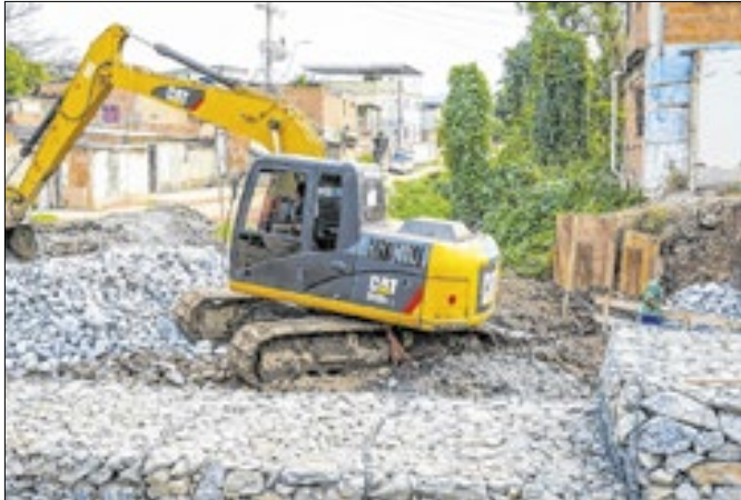
Obras continuam em ritmo acelerado em Jardim Noya
