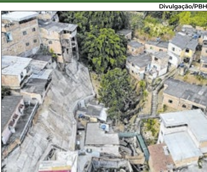
Divulgação/PBH Contenções, urbanização e moradias em vilas e favelas
