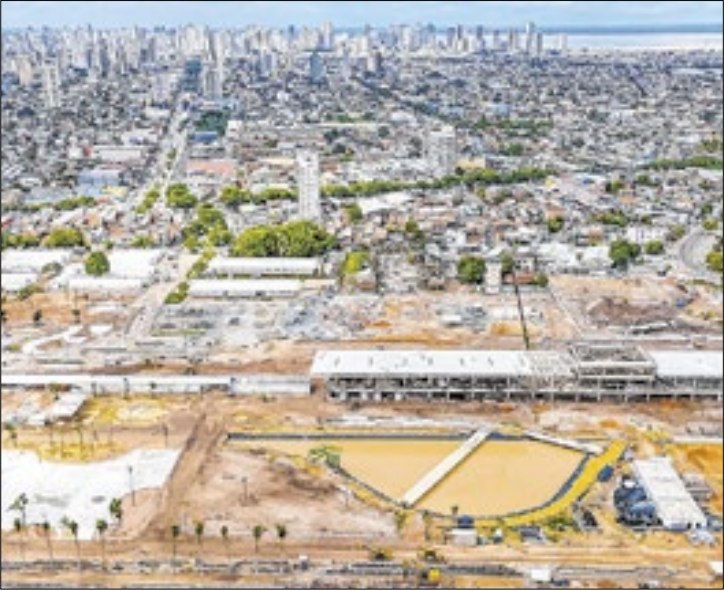
Construção do parque onde será realizada a COP30
