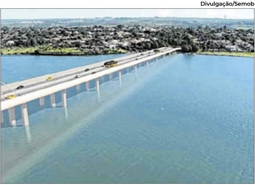
A segunda ponte, que ligará a península norte ao Setor de Mansões do Lago Norte, tem uma estrutura arquitetônica mais simples que a primeira
