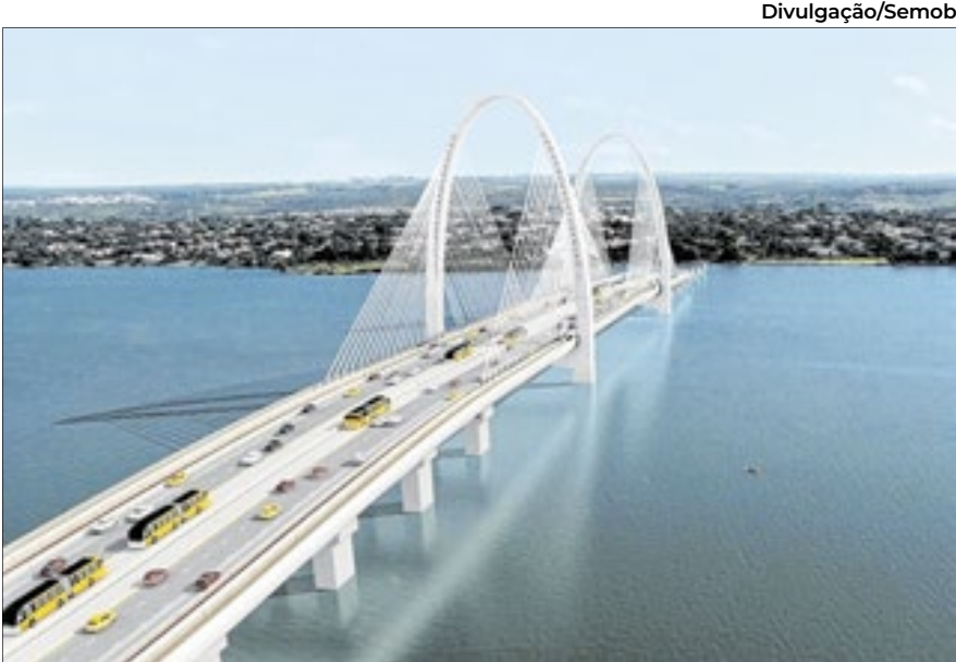
O ponto inicial da nova via será logo após o campus da UnB, numa interseção com a L4 Norte, no início da travessia sobre o Lago Paranoá para a península norte
