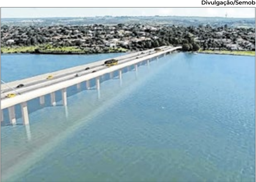
A segunda ponte, que ligará a península norte ao Setor de Mansões do Lago Norte, tem uma estrutura arquitetônica mais simples que a primeira
