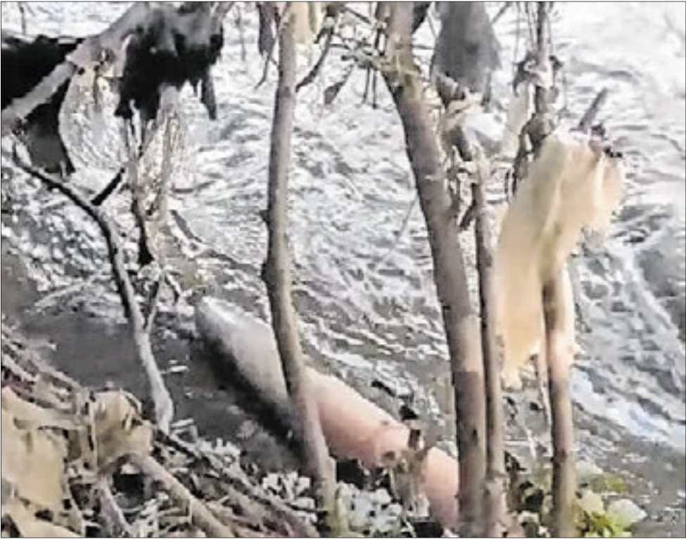
Cano do aterro sanitário que despeja chorume no rio.
