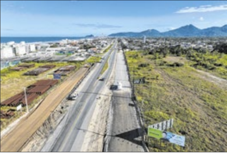
Obra de R$ 274 milhões inclui nova pista em concreto
