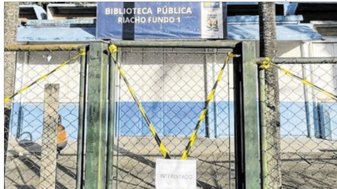
Biblioteca foi fechada por "problemas estruturais"
