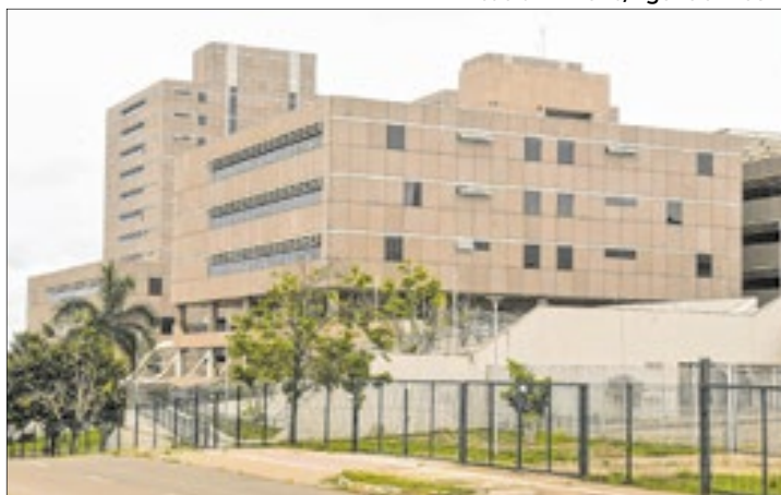
Com uma área de 182 mil m 2 e 16 edifícios, o Centrad foi concebido para centralizar os órgãos do governo distritais
