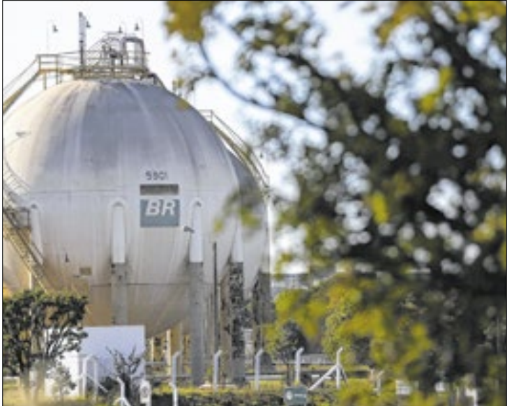
Reservatórios de combustíveis da Transpetro, em Brasília
