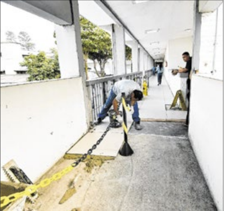
Obras visam melhorar os atendimentos na região
