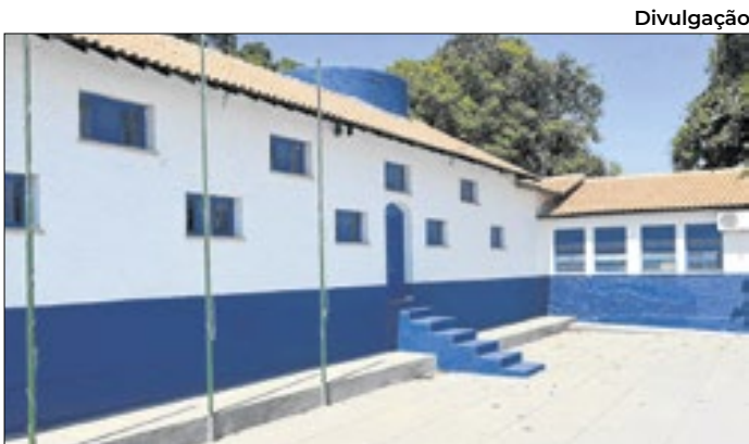
Intervenções realizadas durante as férias
