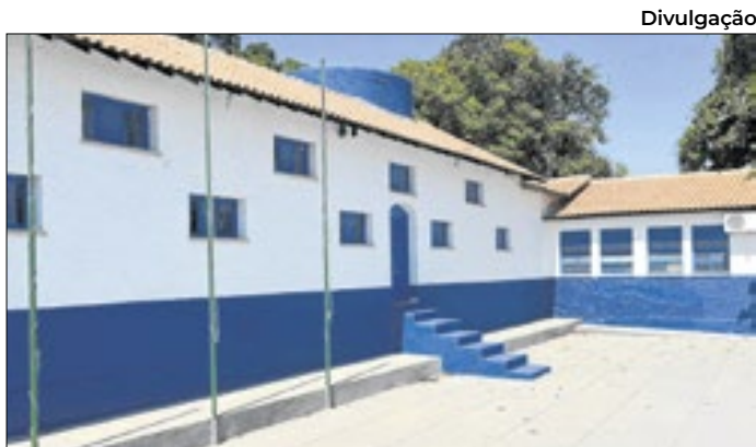
Intervenções realizadas durante as férias
