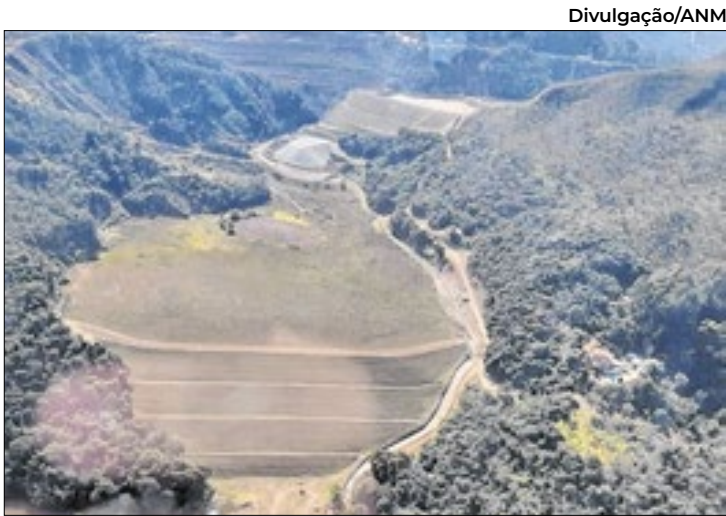
Barragem B1-A, em Brumadinho (MG)
