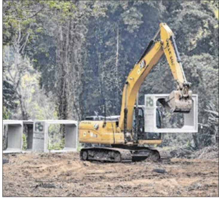
Construção da ETA e de reservatórios começa nos próximos dias
