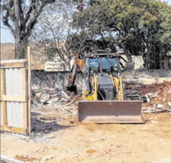
UBS será construída no mesmo local da antiga instalação
