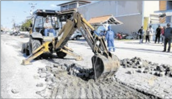
Obras visam revitalizar um trecho da rodovia RJ-106
