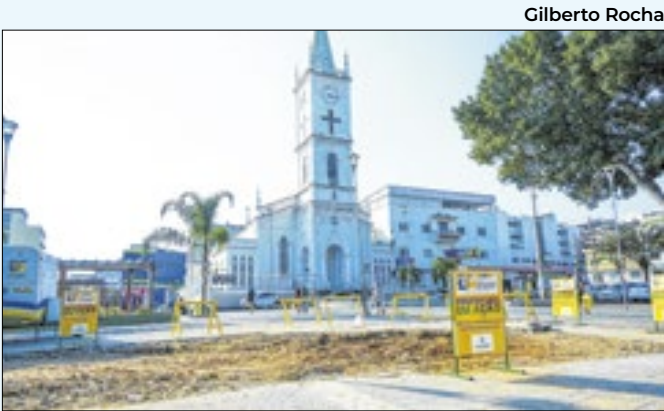
Praça da Matriz após remoção da edificação desativada
