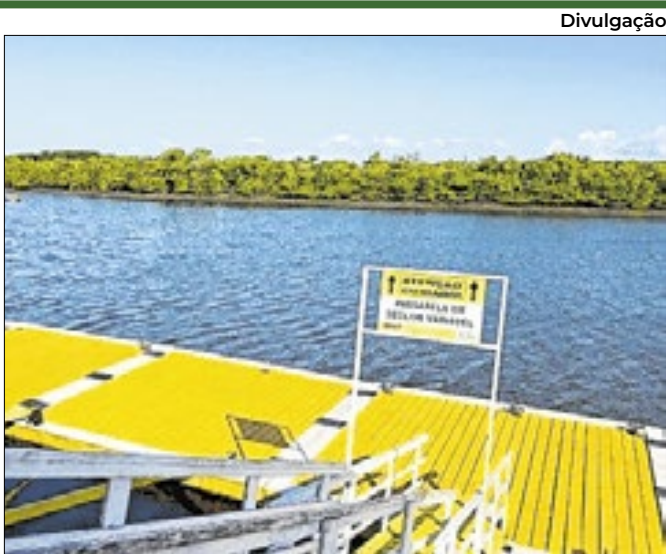
O investimento da obra foi de R$ 2.217.639,26
