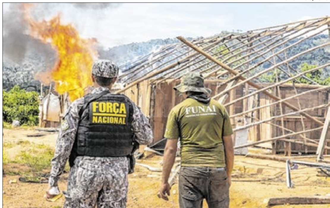
Equipamentos, acampamentos e combustíveis foram inutilizados pela operação em curso
