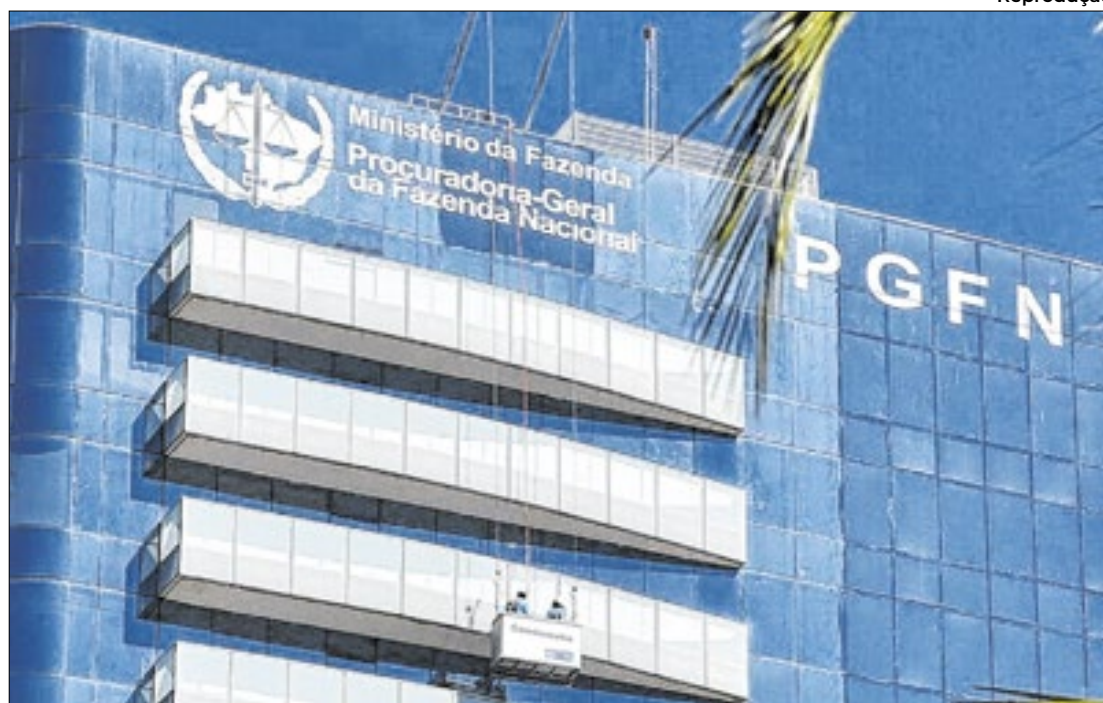
Prédio da Procuradoria-Geral da Fazenda Nacional em Brasília: empresas estão na mira
