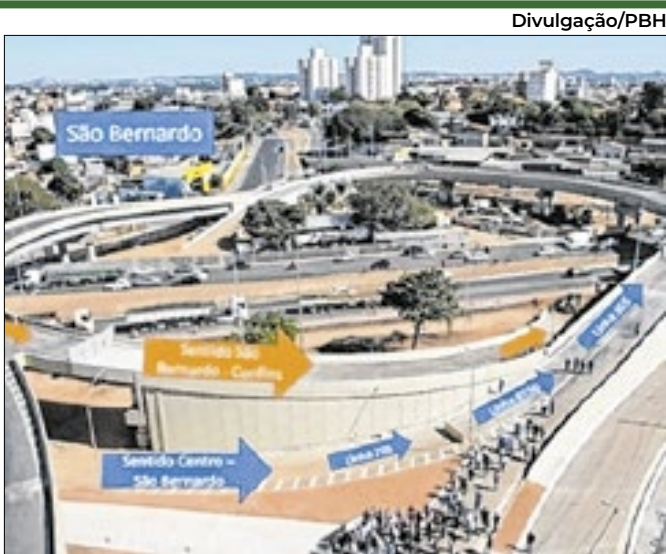
Viadutos na Cristiano Machado ganham ligações
