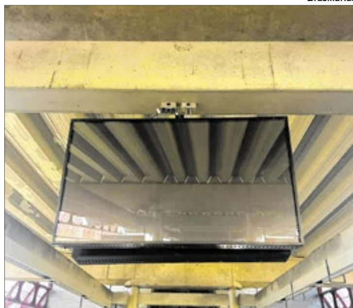
Painéis digitais de informação, na Estação Furnas, em Samambaia, passaram pelo menos uma semana desligados
