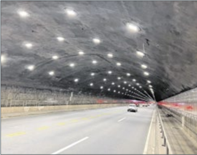
Cerca de 13 Km de luz foram postos nos túneis
