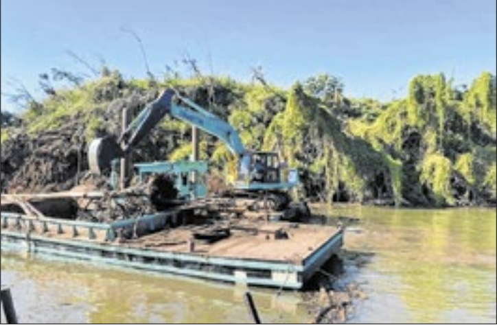
Máquinas realizam serviço em Estrela
