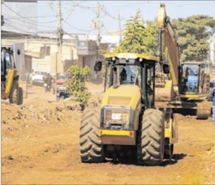
Aproveitando o período de estiagem, as equipes intensificaram a implantação de blocos intertravados nas ruas internas do Sol Nascente
