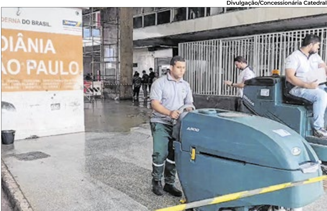
Máquinas pesadas tiram o acúmulo de sujeira do piso de granitina, que voltou a ter a cor original e brilho
