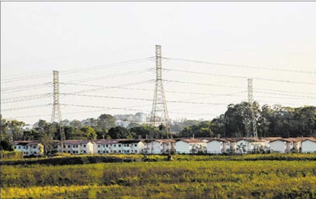
Alta de energia elétrica residencial em maio refletiu a mudança da bandeira tarifária
