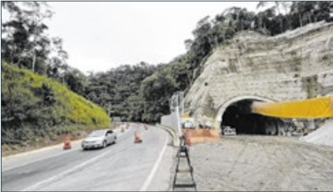
Pelo novo contrato, obra só será entregue em 2029
