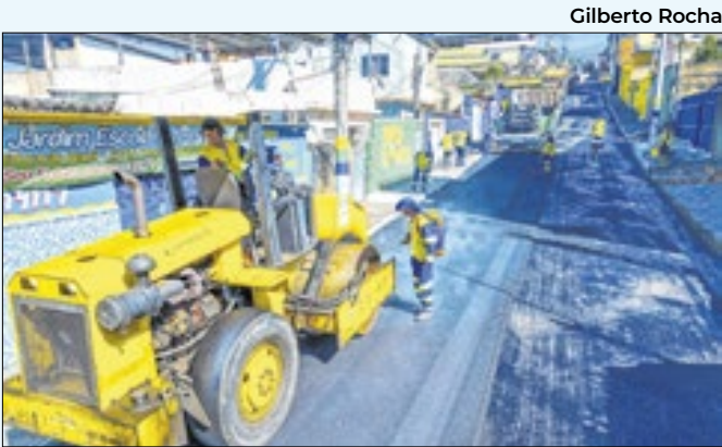
Obras do Transforma Meriti: Meu Bairro de Cara Nova
