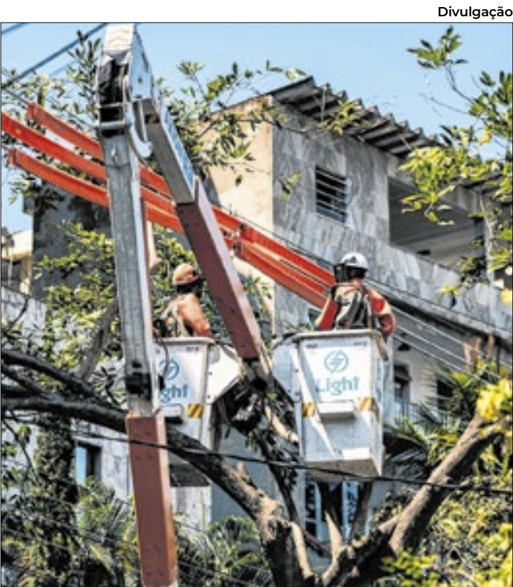
Equipes da Light em operação para resolver problemas de cabeamento
